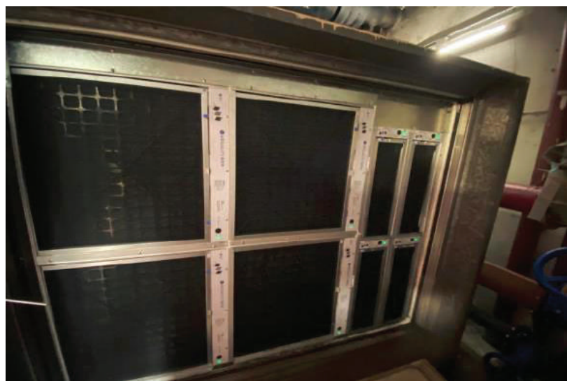
Unitate de tratare a aerului (AHU) Cutie de aer condiționat
