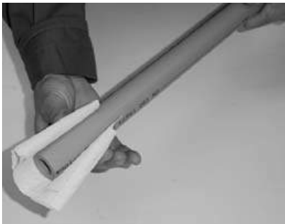
Fig. 4 Se curăță suprafața cu ajutorul uni agent de curățare (exp.: alcool) Clean the joint surfaces with a purifying agent (e. g. spirit).
