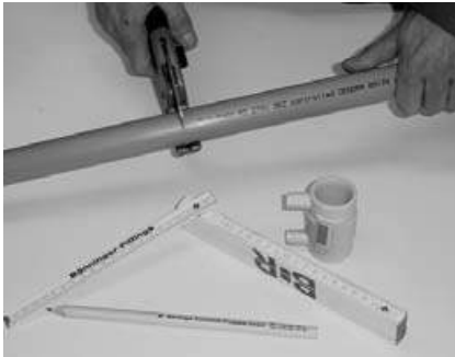
Fig. 1 Cu ajutorul foarfecii sau a unui tăietor de țevă se taie țeava drept. Cut the pipe rectangularly with plastic scissors or with a pipe cutter.
