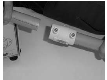
Fig. 6 Se introduc țevile în mufă până la poziția marcată pe țevă. Push in the socket up to the marked position on the pipe.
