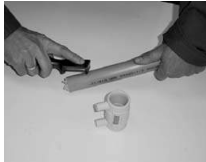
Fig. 2 Cu ajutorul lamei de curățat se îndepărtează stratul oxidat de la exterior. Remove the outside oxide layer using a scraper.
