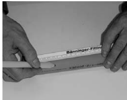
Fig. 5 Se marchează pe țevă adâncimea mufei. Mark out the socket depth.
